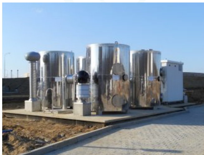
Filtry Bicarbox zblokowane z Draxel (systemem osuszania biogazu SiGa-Tech).
